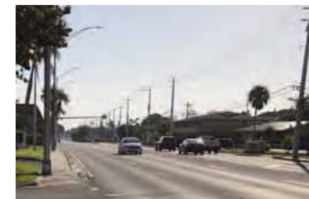
No center lane median until east of NE 19 Av
